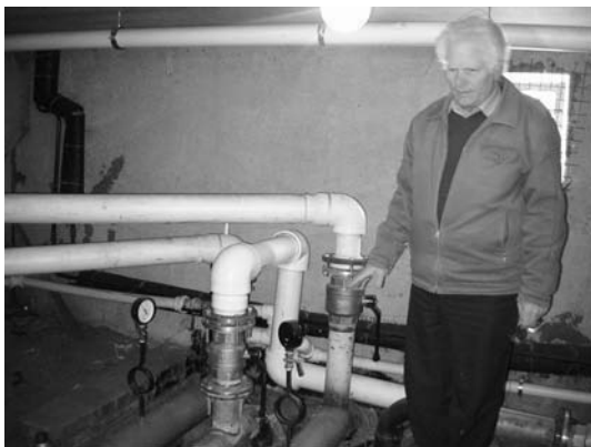
Председатель ТСЖ «Лесной» В.А.Макаренко показывает новые трубы и приборы регулирования системы отопления
