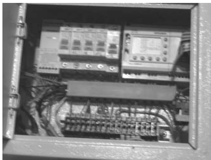
Контроллер – автоматизированный комплекс снятия показаний со счетчиков
