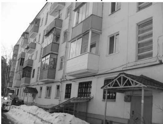
Дом ТСЖ «Содружество» г.Пермь – утепленные балконы, стеклопакеты
